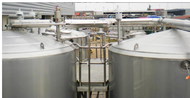
Tanques de gordura
